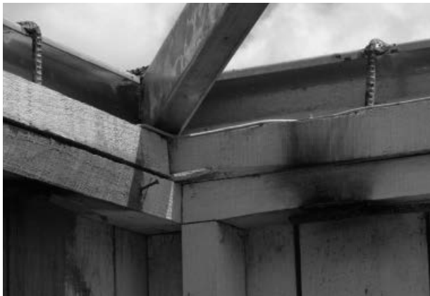
Foto 4. Detalle de montaje de purlings de techo de estructura metálica sobre estructura de madera.
