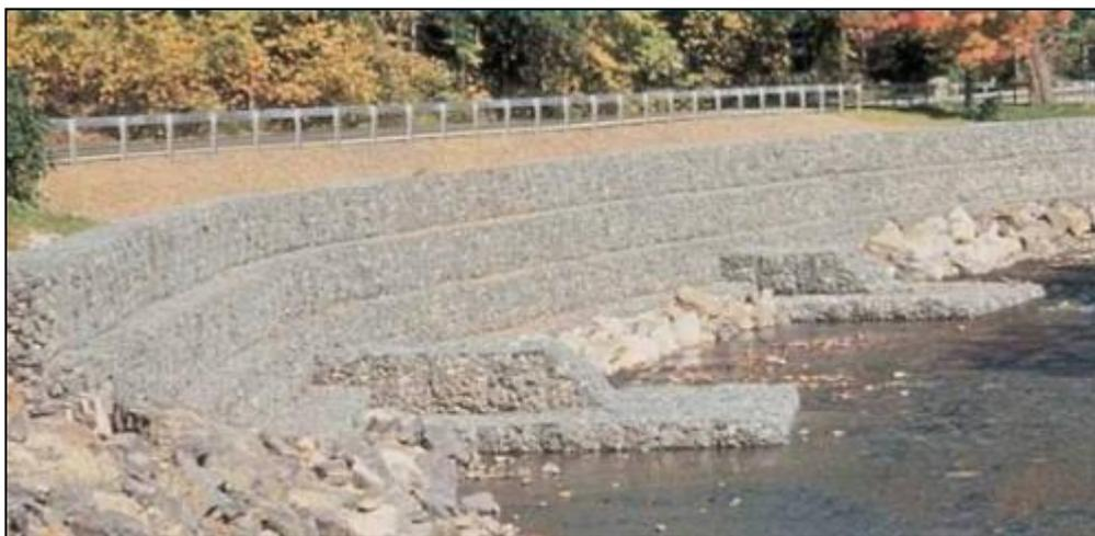
Fig. 90 Exemple d'un gabionnage.
