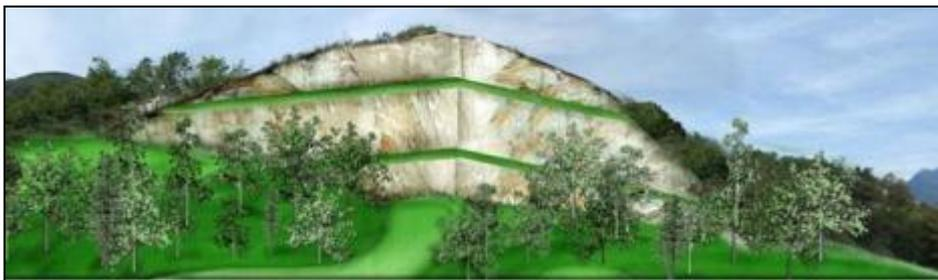
Fig. 141 Éboulement dans une carrière d'extraction matérielle à Petit Goâve (2eme section) et dans la photo en bas modèle de carrière à gradin.
