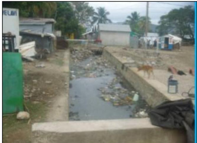
Fig. 89 Centre Ville PETIT GOÂVE: les canaux de drainage sont remplis de déchets, ordures et eaux usées que causent ruissellement urbaine, maladies.
