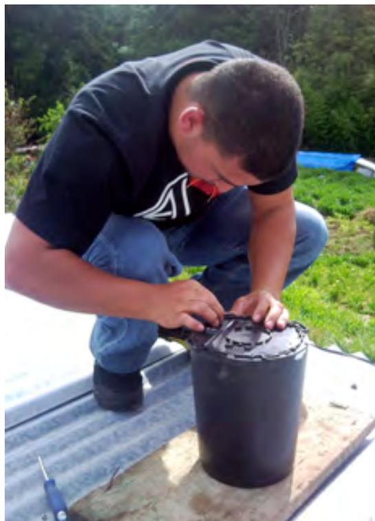
**Foto . Técnico del OSOP instala pluviómetro en el techo de la Oficina de SINAPROC de Cerro Punta, Volcán Barú**
