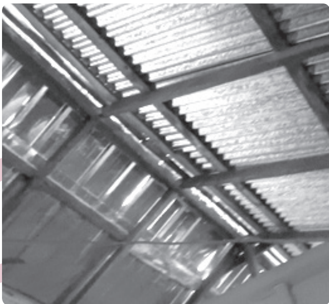
Interior de la casa de Oilda techada
