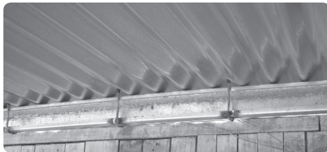
Techos fijados con purlings
