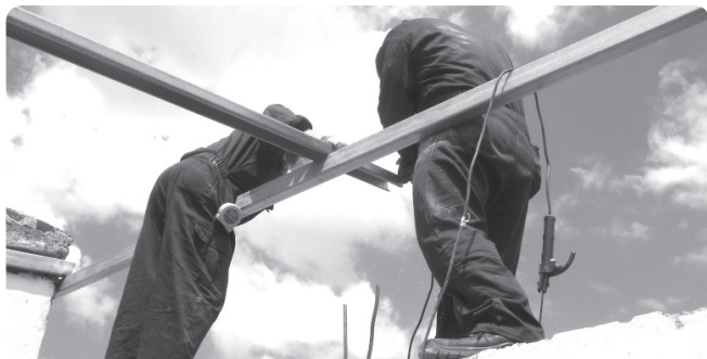
Los techeros de las brigadas comunitarias arreglando la casa de Chicha
