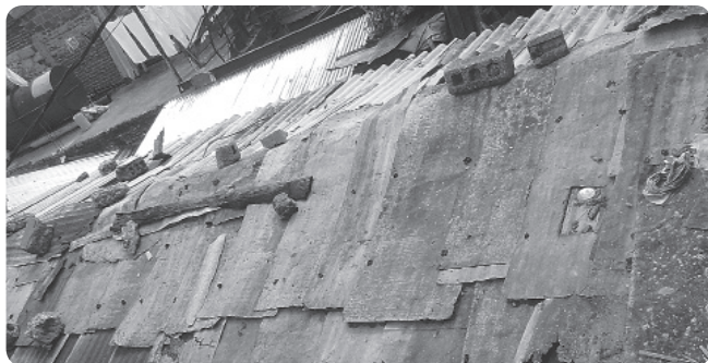
Techo reparado con recursos propios.
