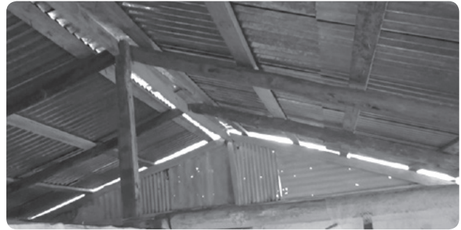
La casa de Chicha techada, luego de la reparación
