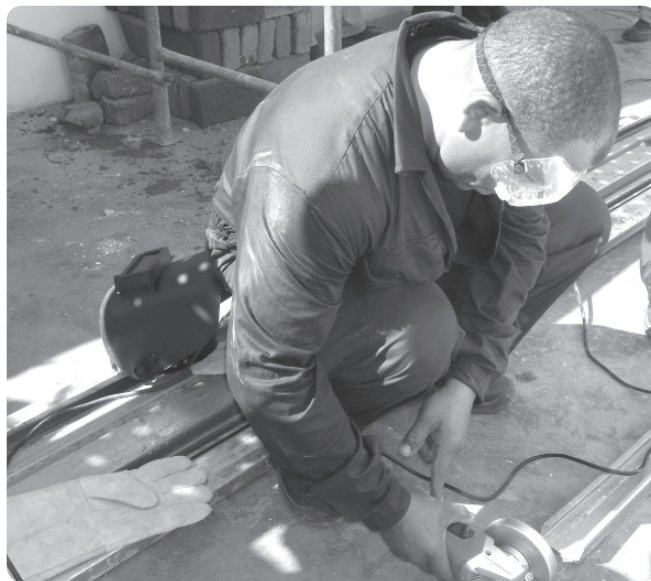
Soldadores durante la colocación de techos
