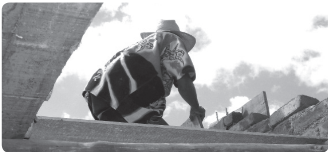
Techeros durante la reparación de viviendas
