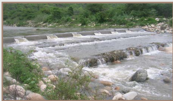
Fig. 5. Captación del sistema de riego en Piedra del Toro - Piura, que incorpora el concepto de resiliencia (flexible para épocas de escasez u abundancia de agua).
