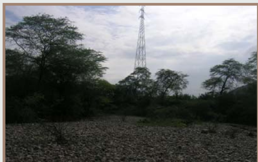
Fig. 2. Ejemplo de vulnerabilidad - exposición: torre de alta tensión ubicada cerca a una quebrada:
