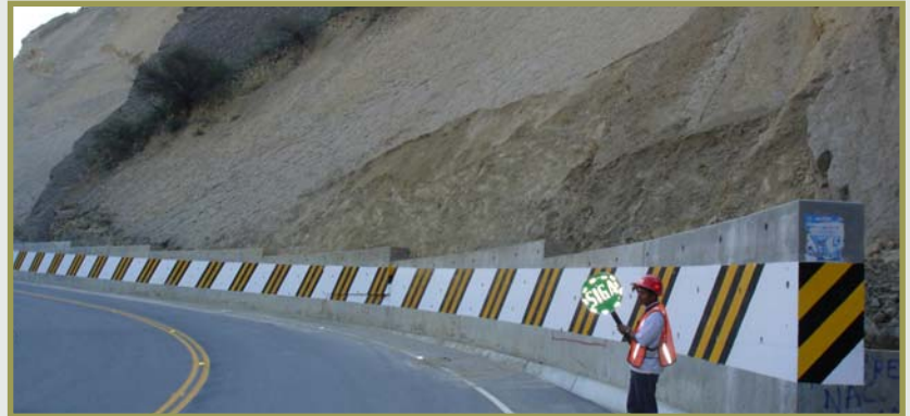
Fig. 22. Construcción de carretera considerando la Gestión del Riesgo: protección de la carretera frente a derrumbes.
