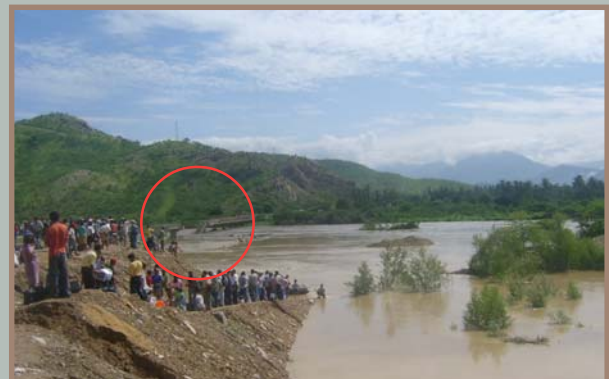
Fig. 7. Ejemplo de baja resiliencia: inicio de desmontaje de puente Carrasquillo (Morropón - Piura) para su rehabilitación en época de lluvias estacionales (febrero 2006).
