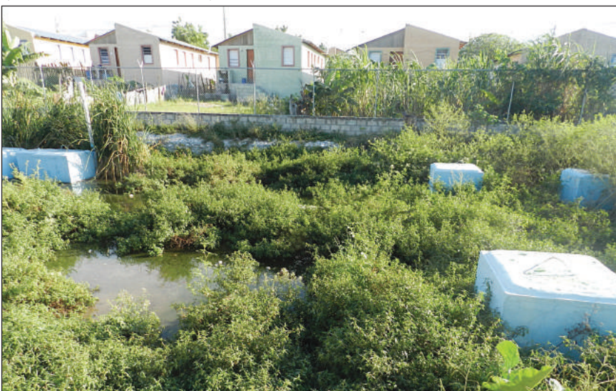
Barrio de Villa Armonía en el Municipio de Jimaní, el sistema de fosas sépticas comunitario se encuentra colapsado por el aumento del nivel freático en la zona. (Jimaní, 21 de noviembre de 2012. Fotografía: Raquel Casares)
